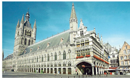
De Lakenhallen zullen een grondige renovatie ondergaan. Foto: Eric Flamand
